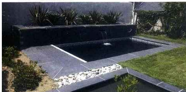
Cette piscine est réalisée avec des panneaux très performants de 0,50 par 1,50 m en polyéthylène recyclé. Faciles et légers (16 kg) à visser, ils permettent de construire une piscine à fond plat. RecyPool de Unipool.
